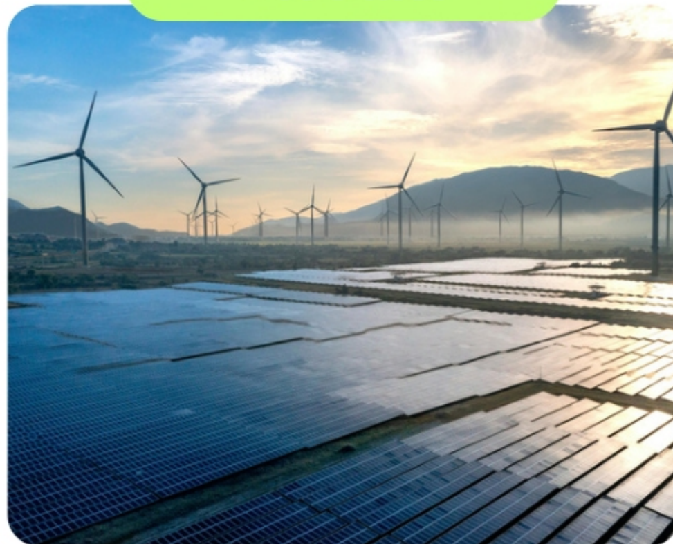
Pembangkit Listrik Tenaga Surya
